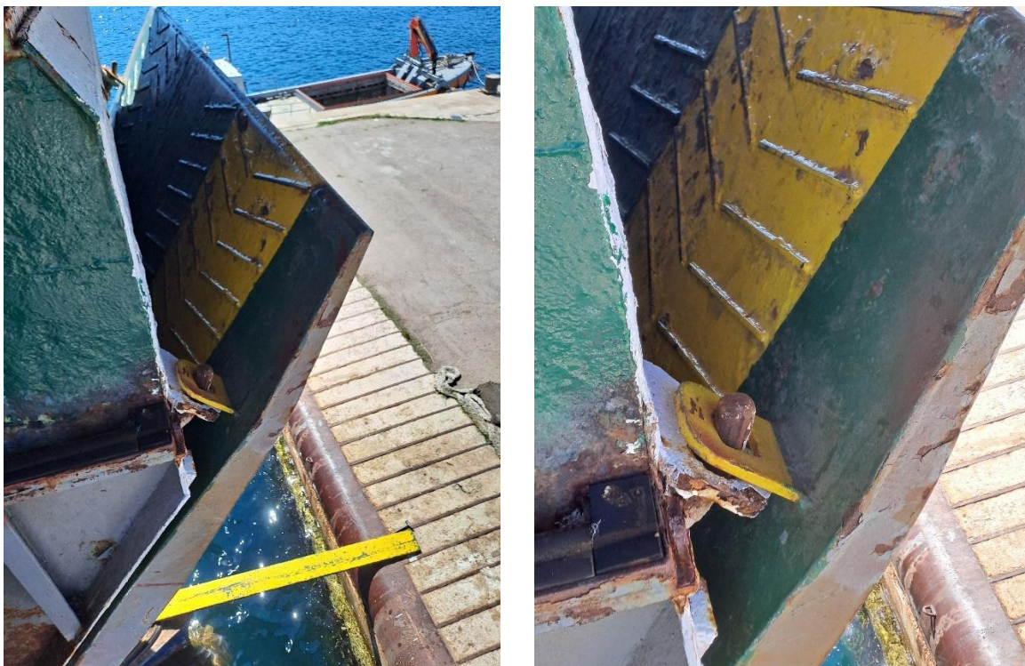
Slika 10. Mehanički osigurana pramčana rampa uglavljivanjem bolcena u uške (lijevo) i detalj uglavljivanja s desne strane pramčane rampe (desno) (izvor: AIN)
