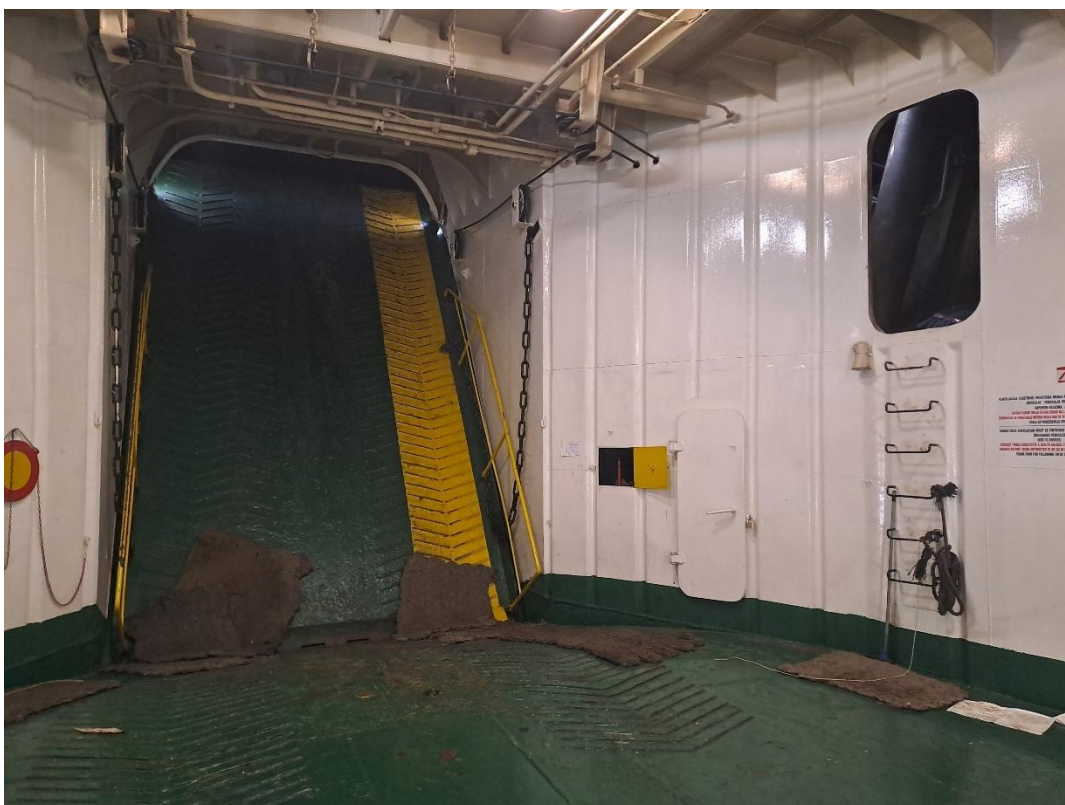
Slika 9. Prikaz pramčanog dijela broda u unutrašnjosti palube vozila (garaže) s pramčanom rampom, otvorom za smještaj ručice za upravljanje pramčanom rampom i prostorom poviše palube kojemu se pristupa ljestvama u kojemu se nalazi hidraulički sklop pramčane rampe (izvor: AIN)
