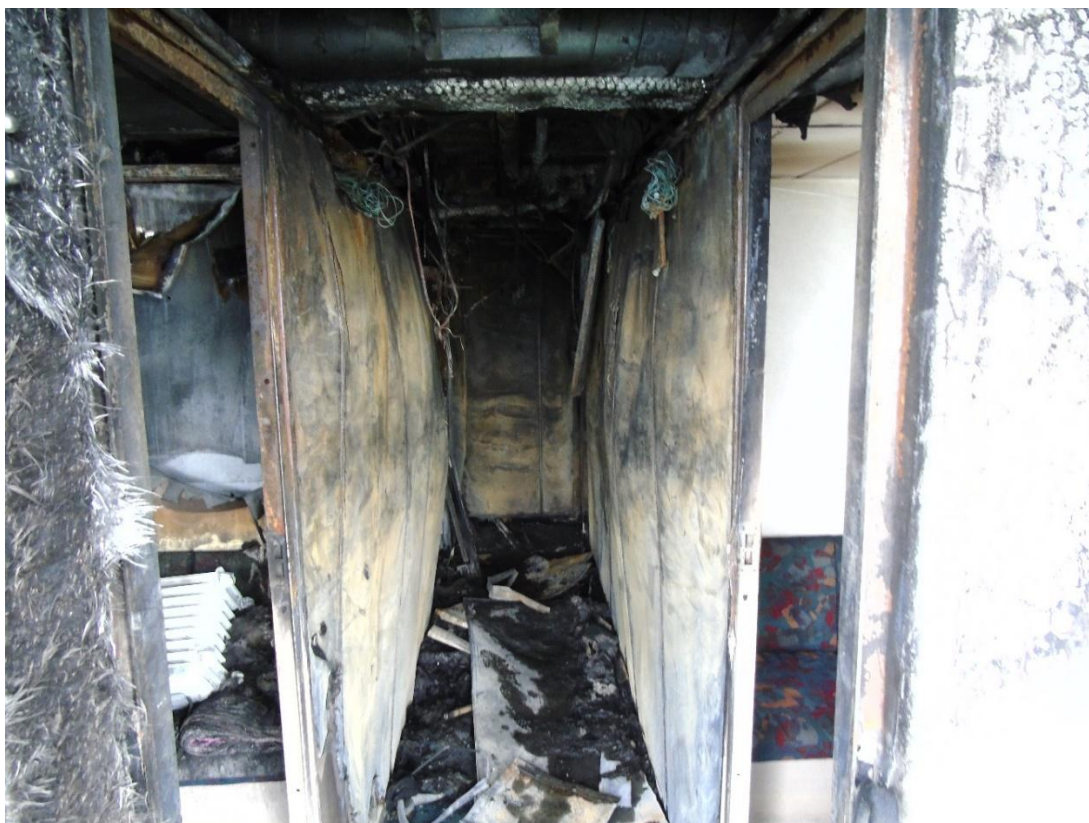
Slika 5. Hodnik, pogled s ulaznih vrata hodnika palube 3 (izvor: AIN)
