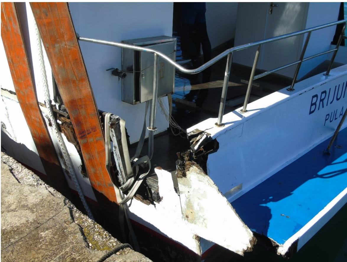
Slika 8. Oštećenja konstrukcije na mjestu nedostajuće krmene bitve, brod „Brijunka“ (izvor: AIN)
