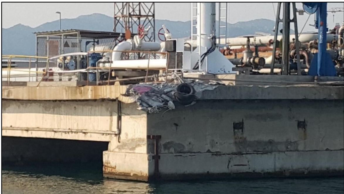
Slika 4. Dio oštećenog pristana (servisna platforma) terminala za prekrcaj tekućih tereta nakon isplovljenja broda „STI Poplar“ 8. kolovoza 2018. godine (izvor: AIN)
