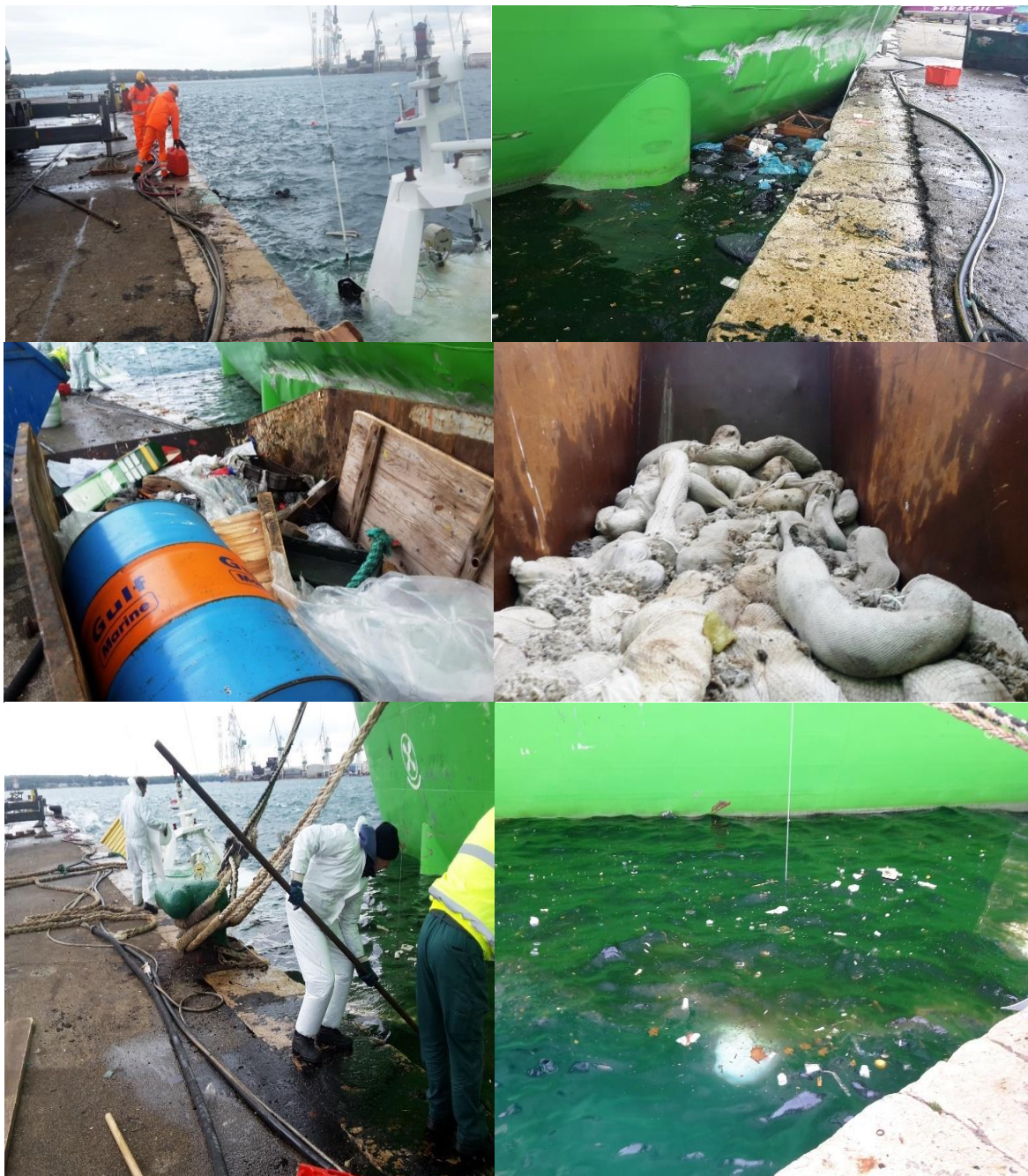
Slika 24. Vađenje i zbrinjavanje krutog otpada te sanacija uljnog onečišćenja
