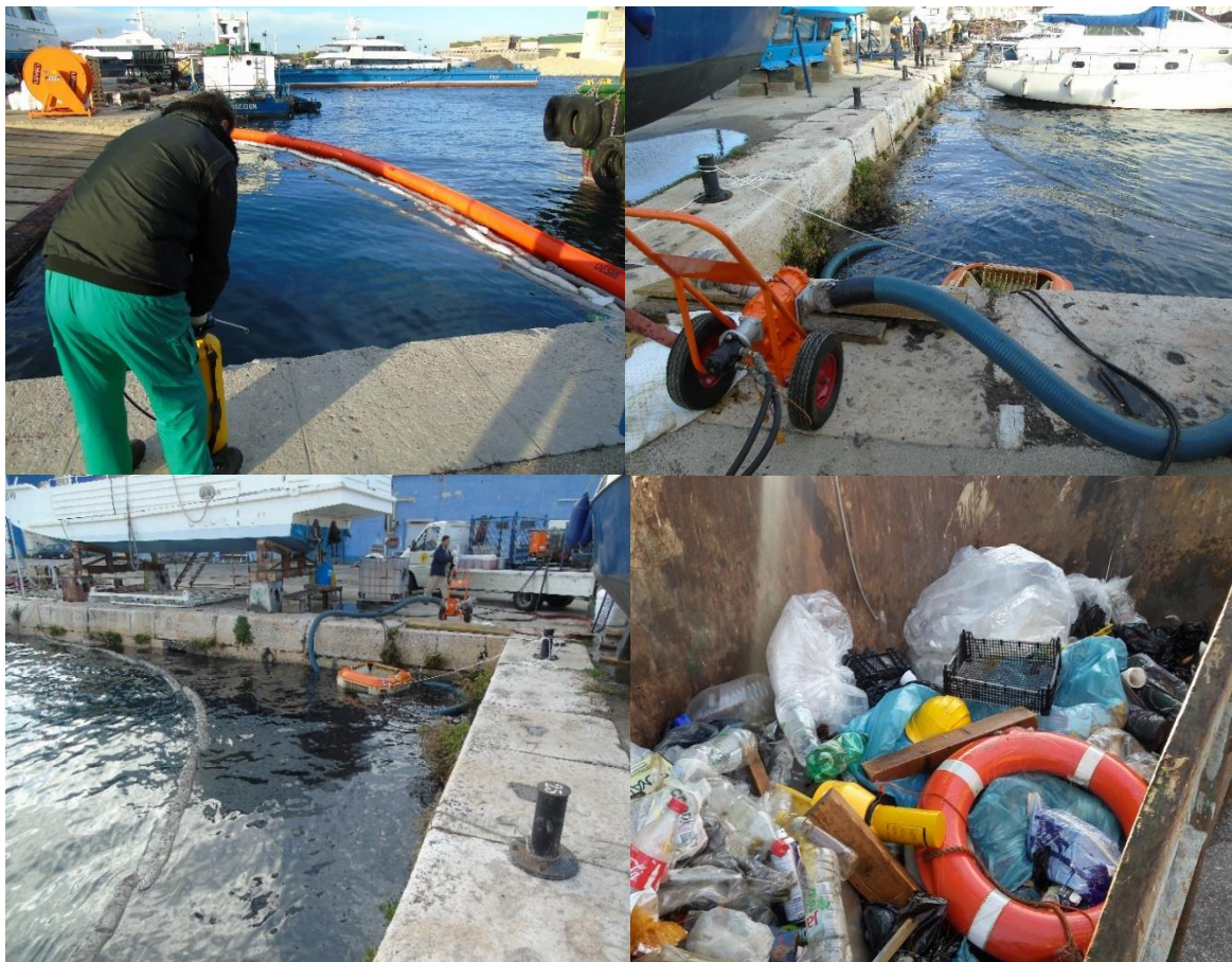
Slika 21. Akcije sprječavanja širenja te prikupljanja zauljenih voda i krutog otpada (izvor: AIN)
