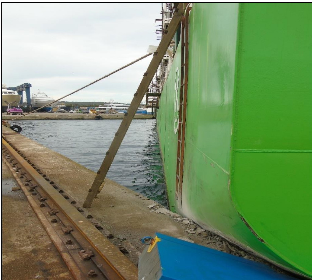
Slika 13. Vidljiva oštećenja na Obali IX i krmenom (lijevom) dijelu platforme uslijed udara platforme u obalu (izvor: AIN)
