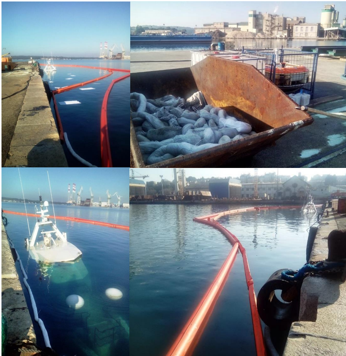
Slika 29. Nastavak saniranja istjecanja zauljenih voda s broda „Silni“ (izvor: LK Pula)
