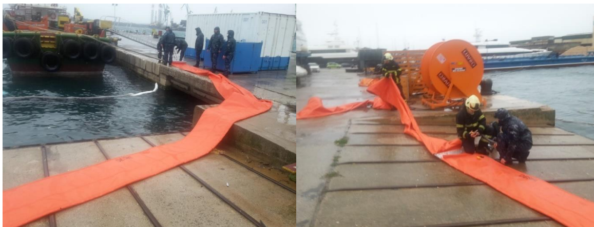
Slika 20. Postavljanje upijajuće i brane na napuhavanje na izlazu iz kanala koji prolazi ispod gata (izvor: LK Pula)
