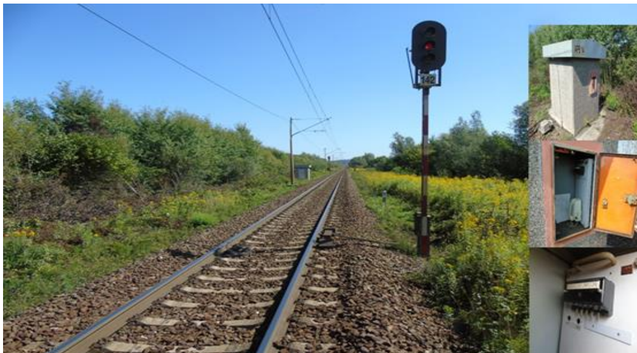
Slika 12. APB kućica s telefonskim ormarićem (Izvor slike: AIN)
