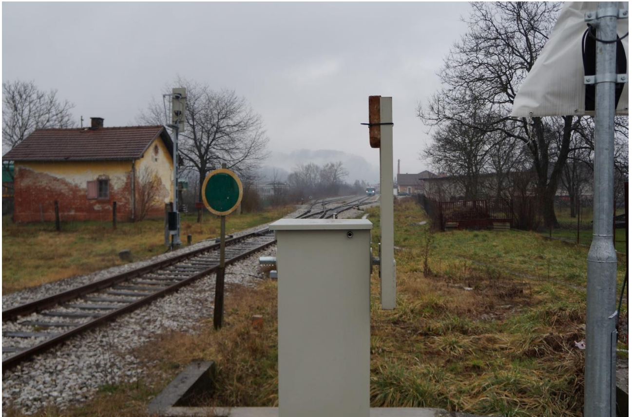
Slika 4. – Pogled od strane ŽCP Gornja Stubica u smjeru dolaska vlak 3229 (izvor slike: AIN)
