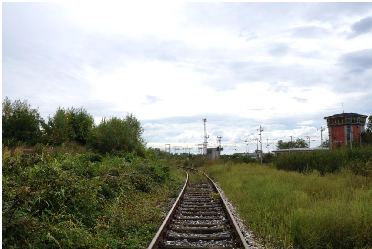
Slika 5. – Opći snimak pozicije s koje je krenuo TMD 9103 prema „Z“ kolosijeku (izvor slike: AIN)
