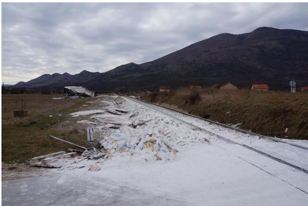
Slika 7 Onečišćenje gornjeg ustroja pruge i prikaz uništenog tereta (Izvor AIN)
