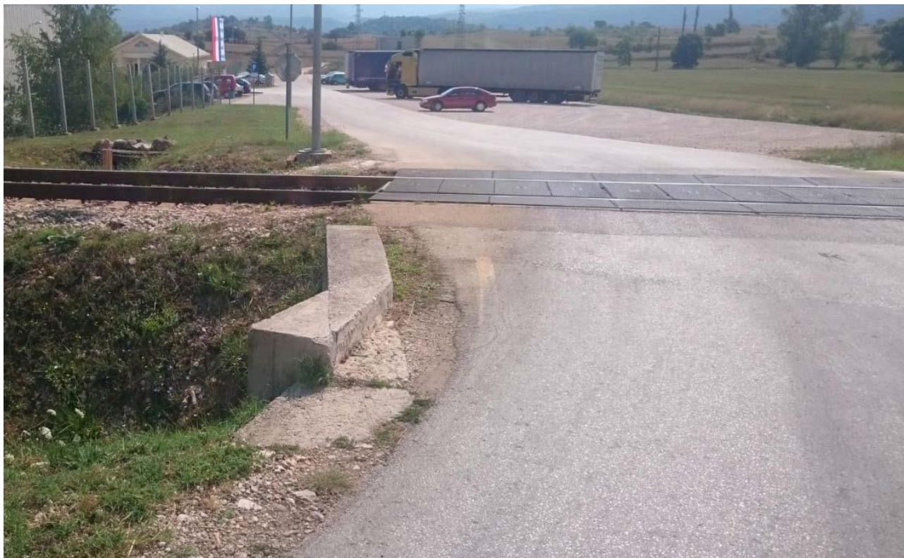
Slika 10. Širina kolnika u odnosu na širinu ŽCP-a Tvornica Knauf, pogled sa zapadne strane (fotografirano 11. 8. 2015.)
