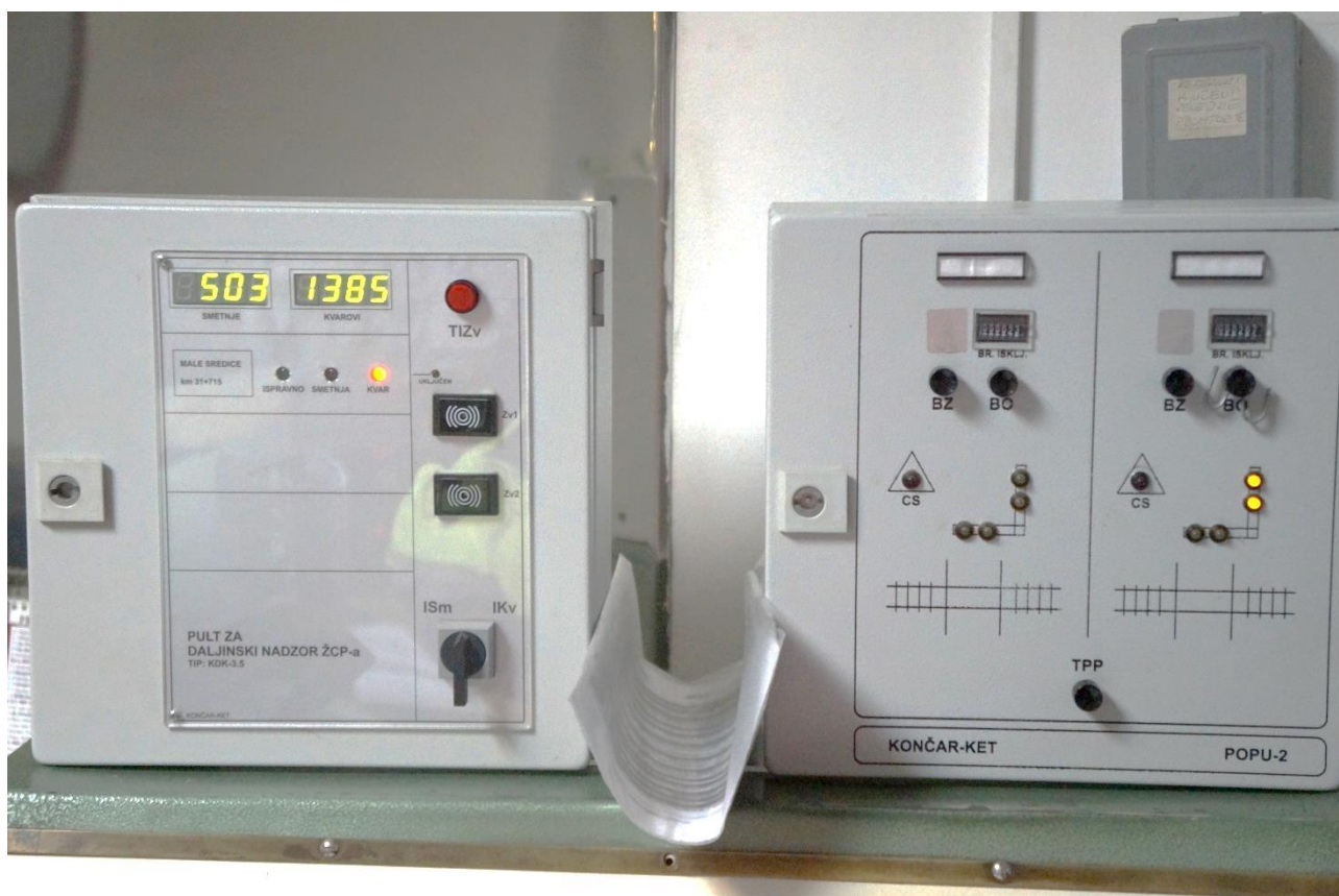
Slika 4. Pult za daljinsko upravljanje i daljinski nadzor rada ŽCP-a (izvor AIN)
